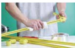
1. Antes da colocação da fita de proteção, a tubulação deve estar limpa e seca. Utilizar somente a fita de alumínio de máxima aderência SIGAS Termofusão®.
