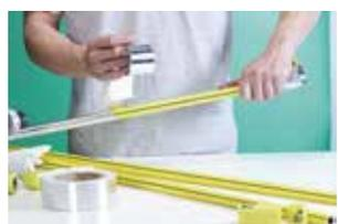
3. Uma vez coberta cada conexão, a proteção anti-UV deverá ser colocada no resto da tubulação. Para tal efeito, a fita deve ser aplicada de forma helicoidal sobre os
