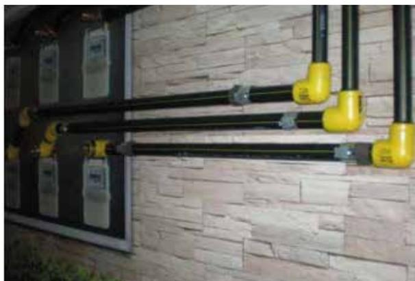
Para aplicações aparentes ou expostas aos raios ultravioleta o sistema especificado é o Sigas Termofusão Preto (UV). Disponível nos diâmetros 20mm até 110mm. Produto com 25 anos de garantia atendendo a norma de desempenho NBR 15575
