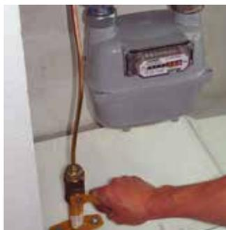
1. Se a tubulação está com carga, deve-se cortar o fornecimento de gás do local, fechando o registro de entrada do edifício. Previamente, certificar-se de que todos os aparelhos estejam desligados.
