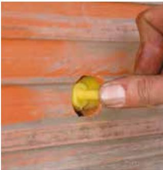
6. Completando o ciclo de aquecimento de etapa dupla, retire o termofusor rapidamente e coloque a sela exercendo pressão suave sobre ela, sem produzir nenhum movimento por 30 segundos. O processo de termofusão da sela se completa com o processo natural de resfriamento.
