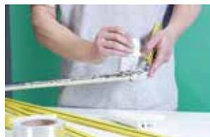
4. Nos encontros de tubos e conexões, o isolamento dos tubos deverá avançar até cobrir a proteção isolante da conexão previamente aplicada.
