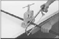
**b)** Cortar o tubo no esquadro e remover as rebarbas, medindo em seguida o comprimento máximo da rosca a ser feita para evitar abertura em excesso;
